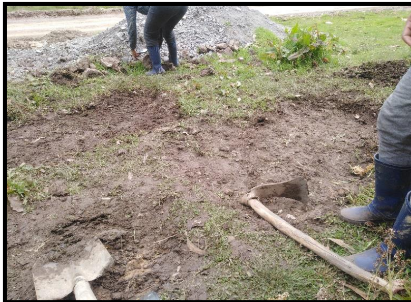
Fotografía 46. Nivelación del lugar donde se construyó los arcos.
