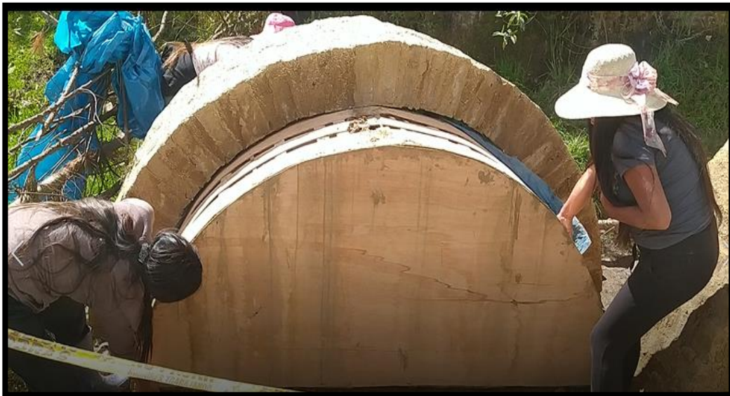
Fotografía 56.Desencofrado del arco de Medio Punto
