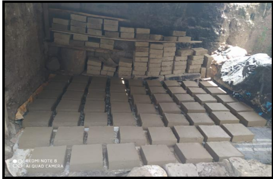
Fotografía 26. Adobes retirados del sol
