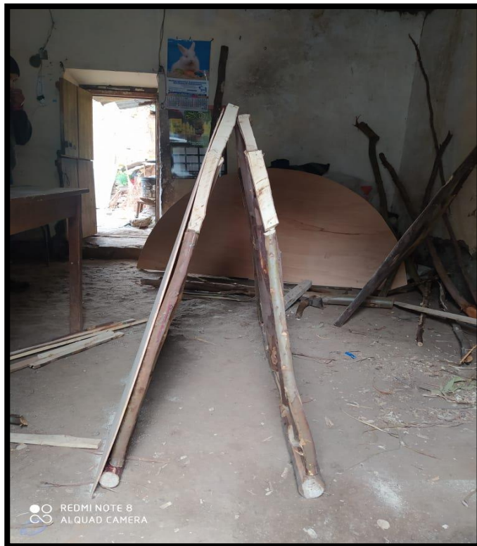
Fotografía 40. Dos piezas clavadas del arco ojival.
