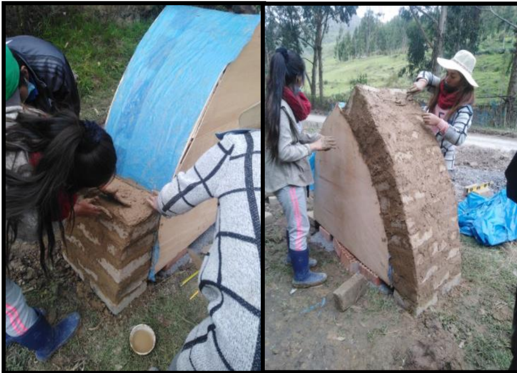
Fotografía 50. Construcción del arco ojival.
