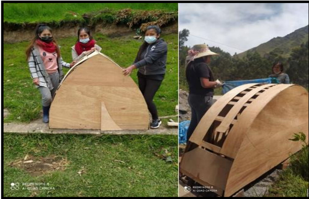
Fotografía 43. Las Cimbras terminados
