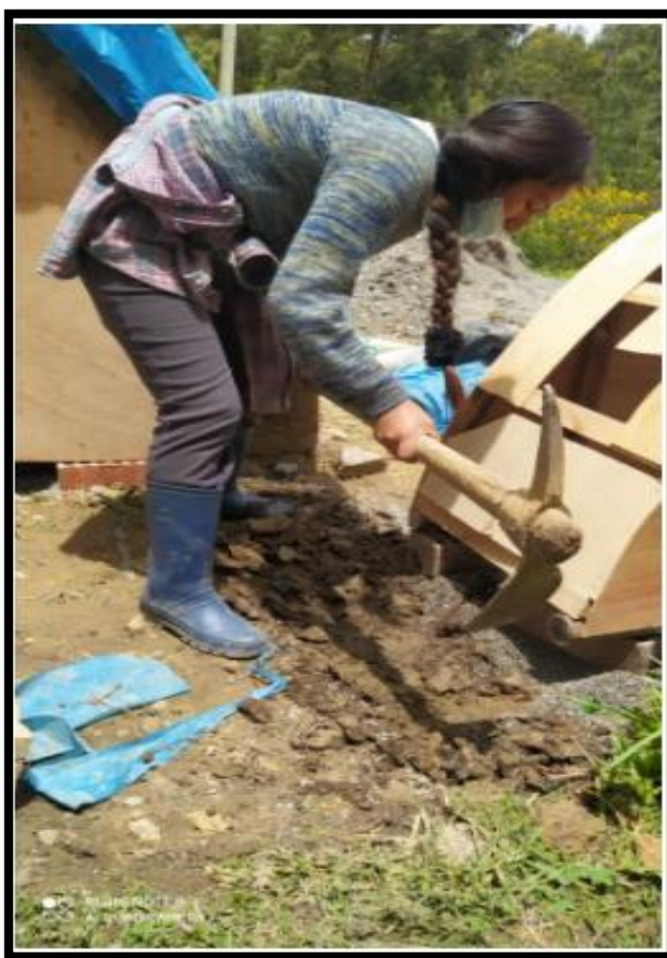
Fotografía 47. Excavación para zapata.
