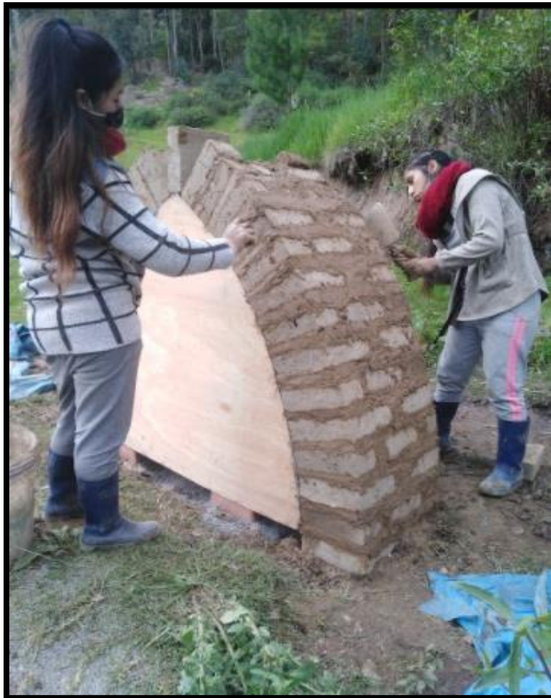
Fotografía 51. Construcción del arco ojival.
