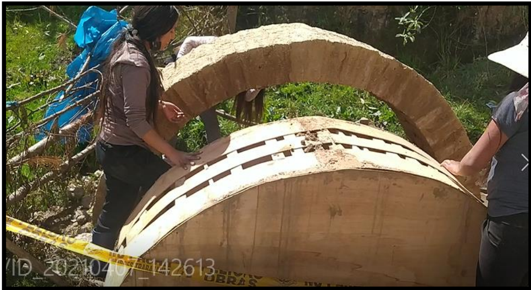
Fotografía 57. Desencofrados del arco medio punto.
