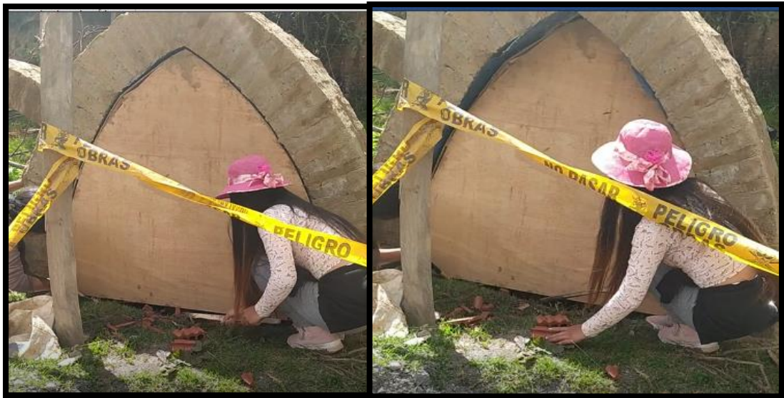
Fotografía 54. Desencofrado del arco Ojival
