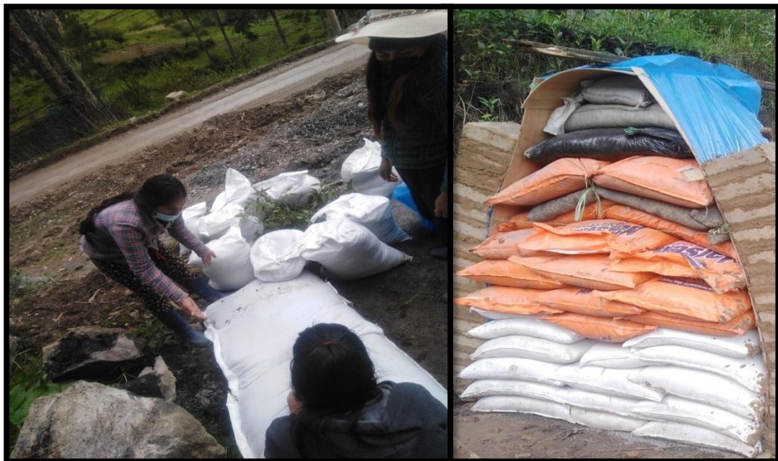
Fotografía 44. Armado de moldes a base de costales y con arena y triplay.
