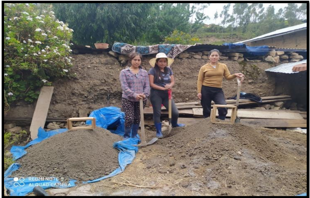
Fotografía 19.Preparación de mezclas para ambos tipos de adobes
