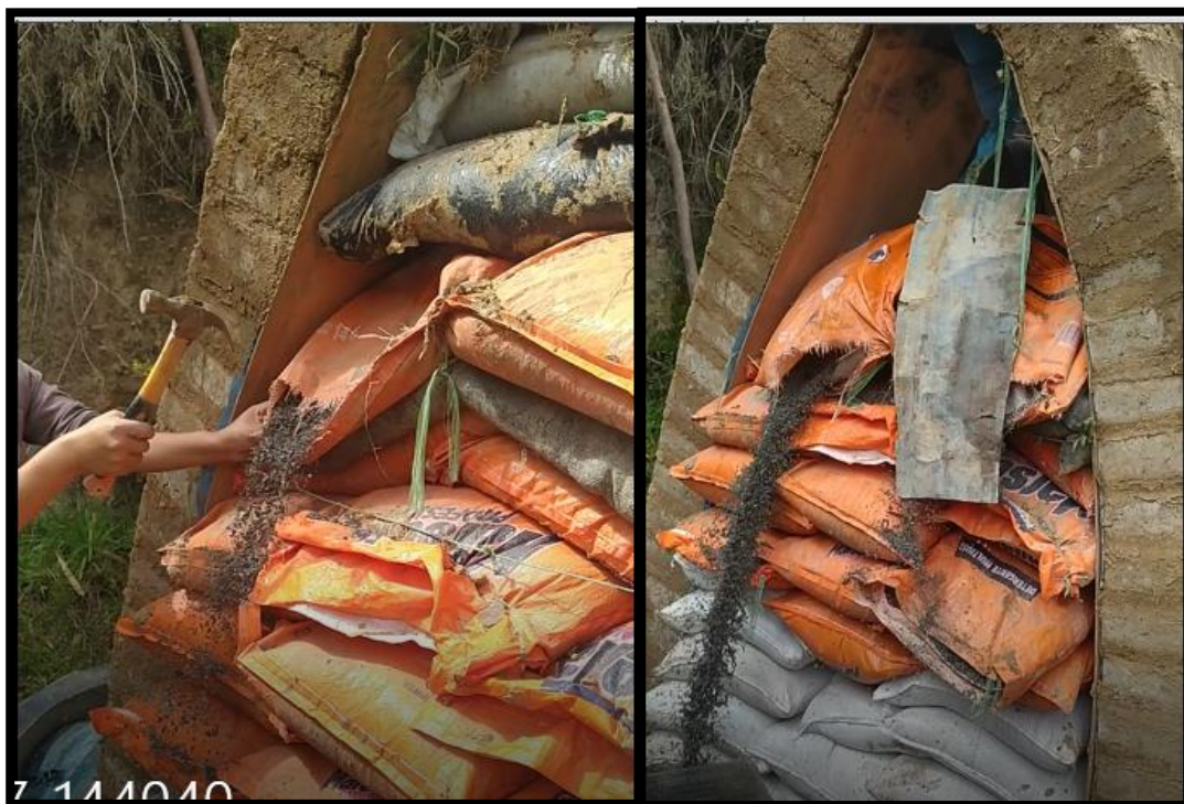
Fotografía 58.Desencofrado del arco Parabólico
