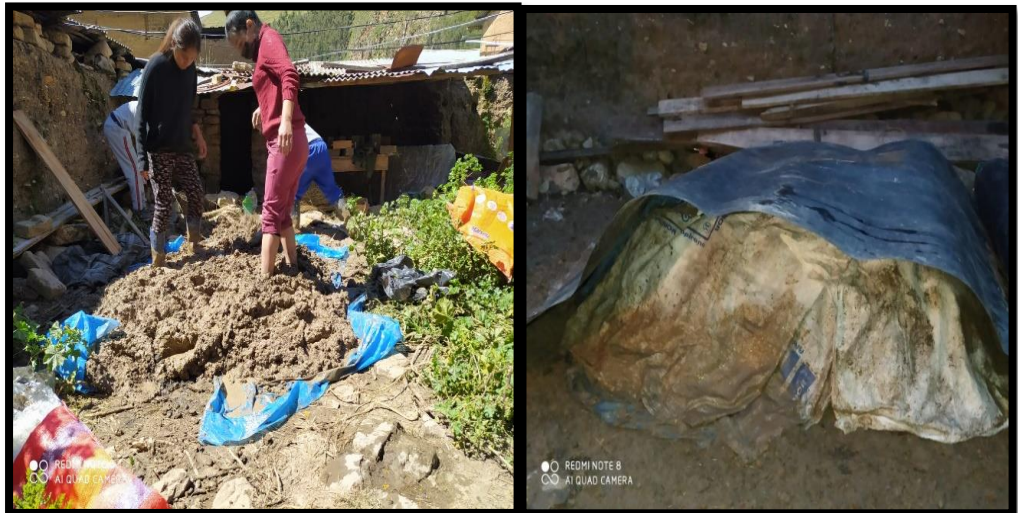
Fotografía 20.verificación de la mezcla
