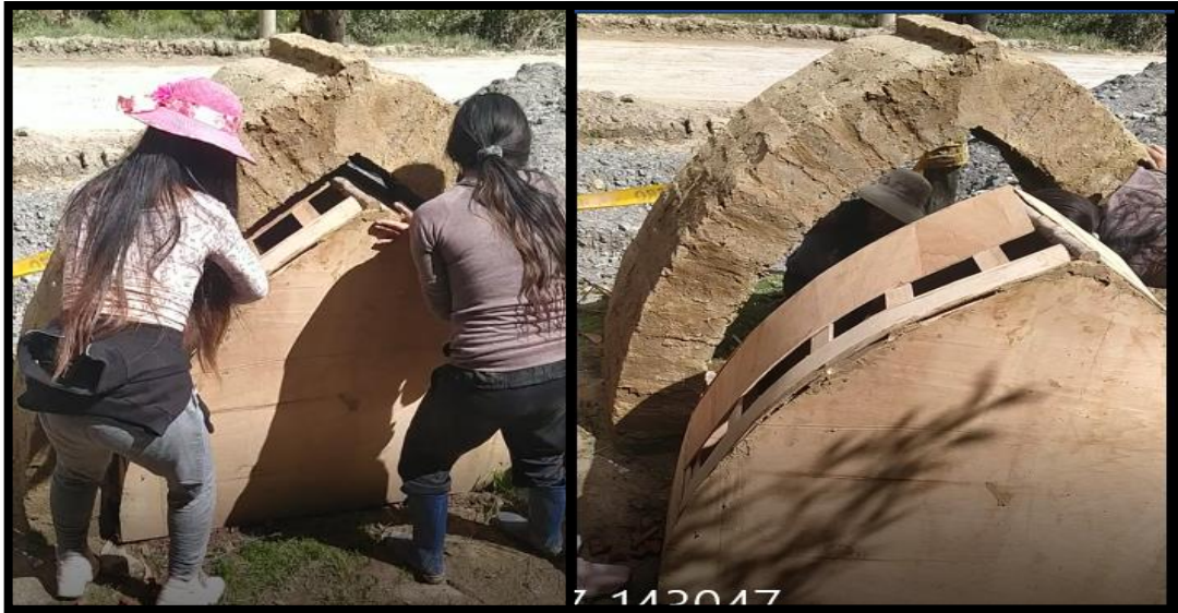
Fotografía 55.Desencofrado del arco tipo Ojival
