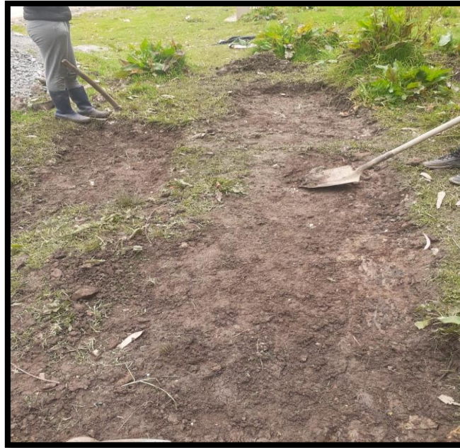
Fotografía 45. Limpieza del lugar donde se construyó los arcos
