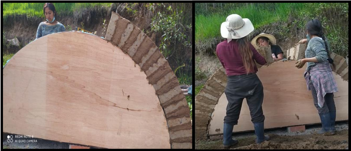
Fotografía 52. Construcción del arco medio punto.
