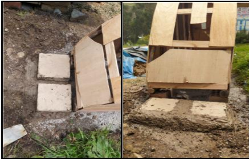
Fotografía 50. Construcción del arco ojival.
