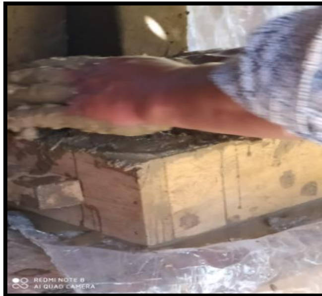
Fotografía 22. Vaciado de la mezcla al molde
