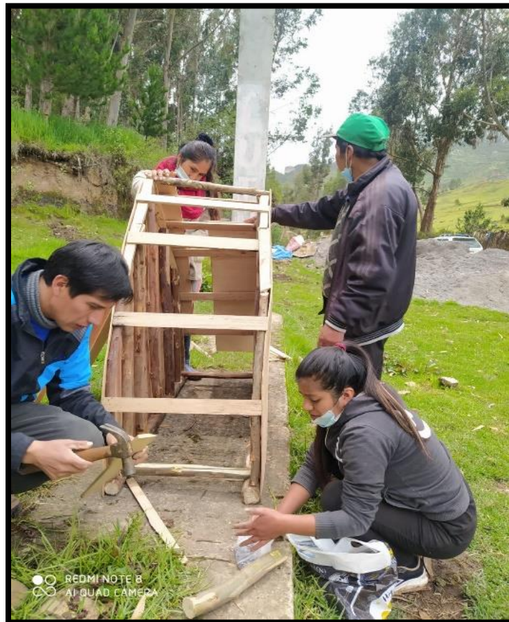
Fotografía 42. Unión de maderas al contorno de cada molde para mayor resistencia.
