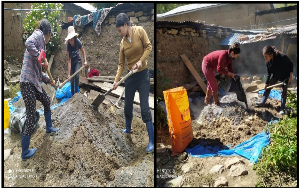
Fotografía 18. Preparación de la mezcla
