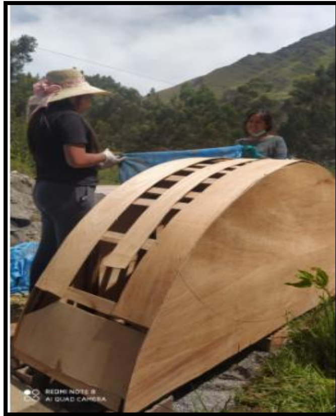
Fotografía 48. Colocación de la cimbra.
