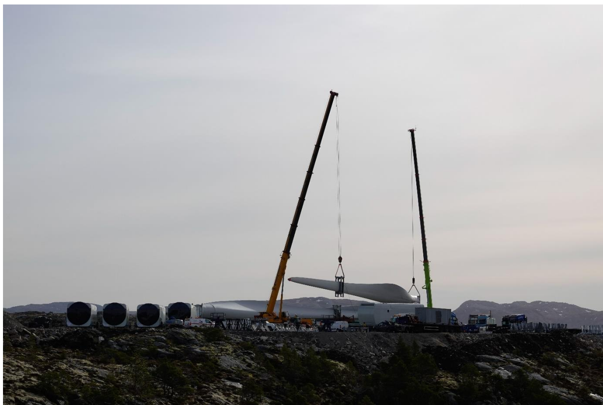
Bilde 3.1. Høye kraner er nødvendig både ved mellomlagring og montering av vindmølledelelene. Bildet er fra Sørmarkfjellet. Foto: Magne Husby.
