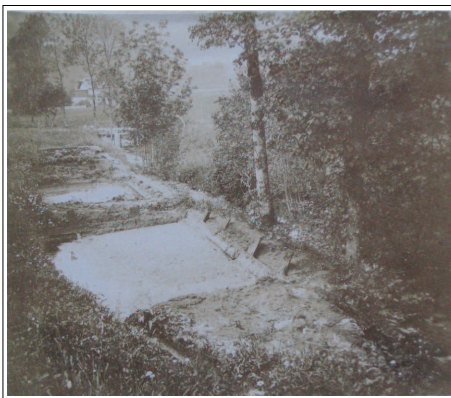
FIG. 7.4 – Les bassins d'épuration de l'usine, juillet 1902.
