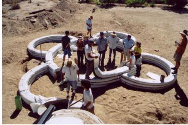
Figura 46: Processo de empilhamento de sacos de terra em Califórnia, USA ( Earth Filled In [sem data]).
