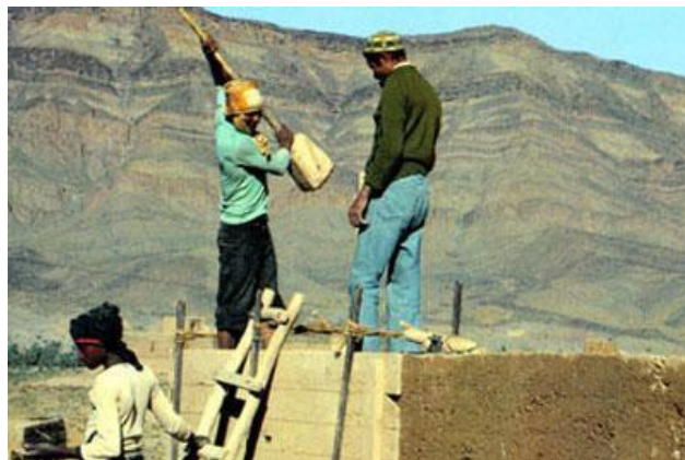
Figura 49: Técnica de construção em Taipa, Marrocos ( Traditional Rammed Earth [sem data]).
