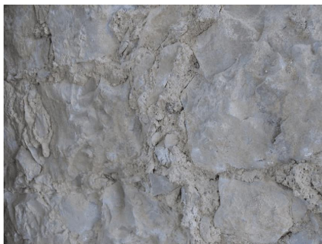
Figura 69: Pormenor de parede de alvenaria de pedra ordinária (Freire 2011, p. 26).
