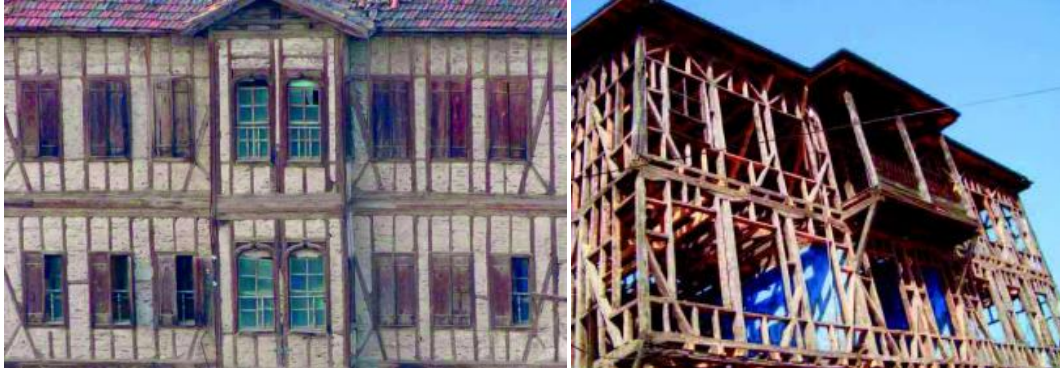
Figura 76: À esquerda - Himis ; À direita - “ Timber Frame ” (Güneş [sem data]).
