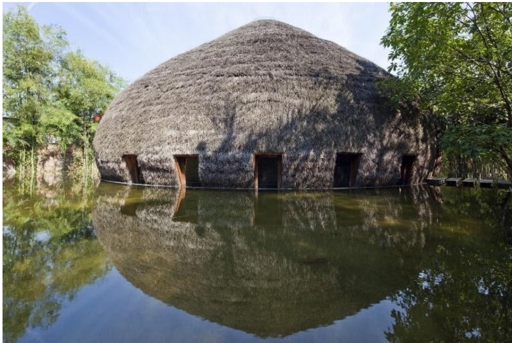
Figura 102: Zona exterior do Wind and Water Bar , rodeada pelo lago artificial (Oki, Quang [sem data]).
