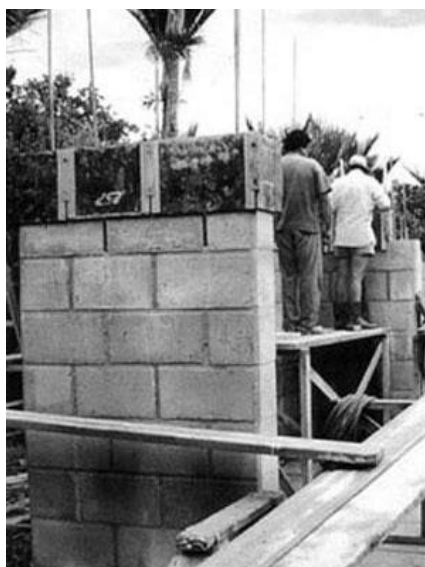
Figura 60 Aplicação da terra em blocos moldados “ In situ ”, Nova Zelândia ( Poured Earth ) [sem data].
