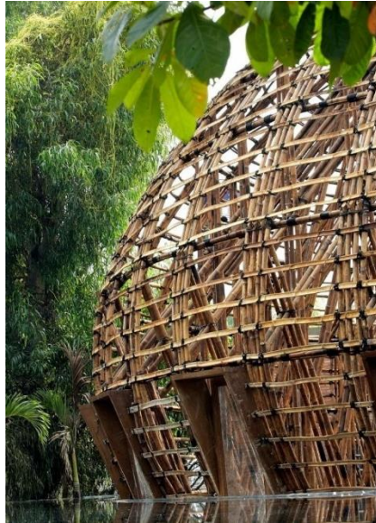
Figura 103: Estrutura em arco, feita de canas de bambu (Oki, Quang [sem data]).
