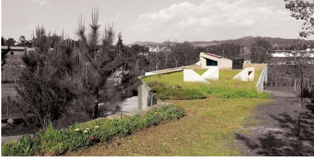
Figura 48: Cobertura ajardinada numa construção contemporânea, Guimarães (Obra Atelier [sem data]).
