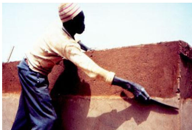
Figura 54; Técnica de empilhamento de terra, Burkina-Faso ( Stacked Earth (cob) [sem data]).
