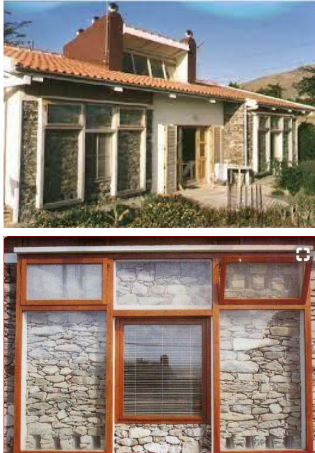
Figura 87: Casa Shäffer , Porto Santo (sistema de parede de Trombe) (Gonçalves, Graça 2004, p. 36).
