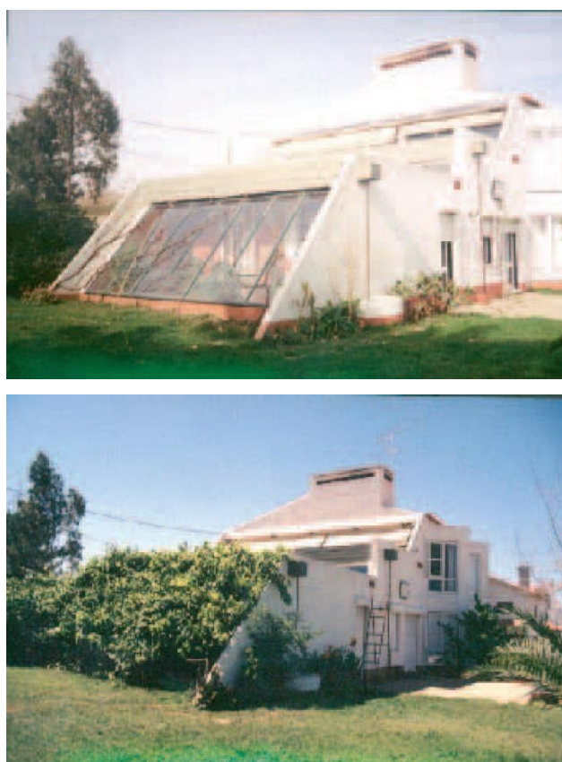
Figura 89: Moradia unifamiliar com sistema de Estufa em altura de Verão e Inverno, Vale do Rosal (Sousa 2018).
