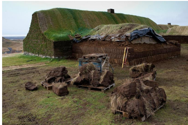
Figura 58: Manutenção de uma casa construída em turfa, Islândia (Bjarnason [sem data]).
