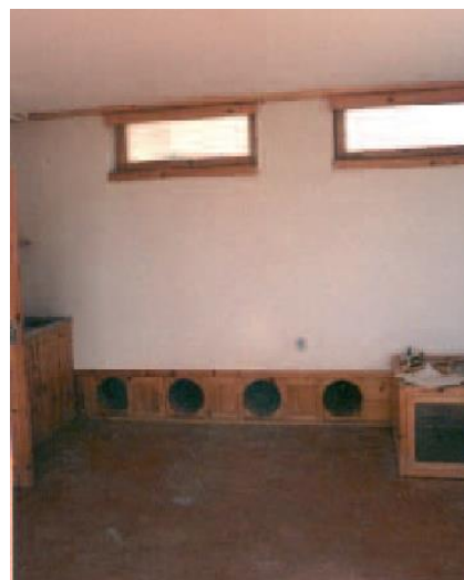
Figura 93: Entrada exterior e interior dos tubos enterrados da Casa Solar, Porto Santo (Gonçalves, Graça 2004, p. 44).
