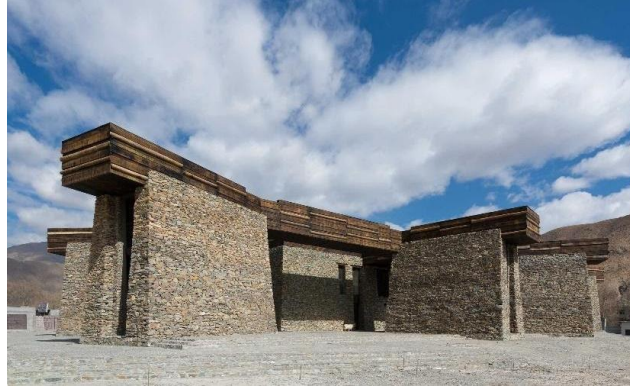
Figura 107: Jianamani Visitor Center ( Jianamani Visitor Center [sem data]).
