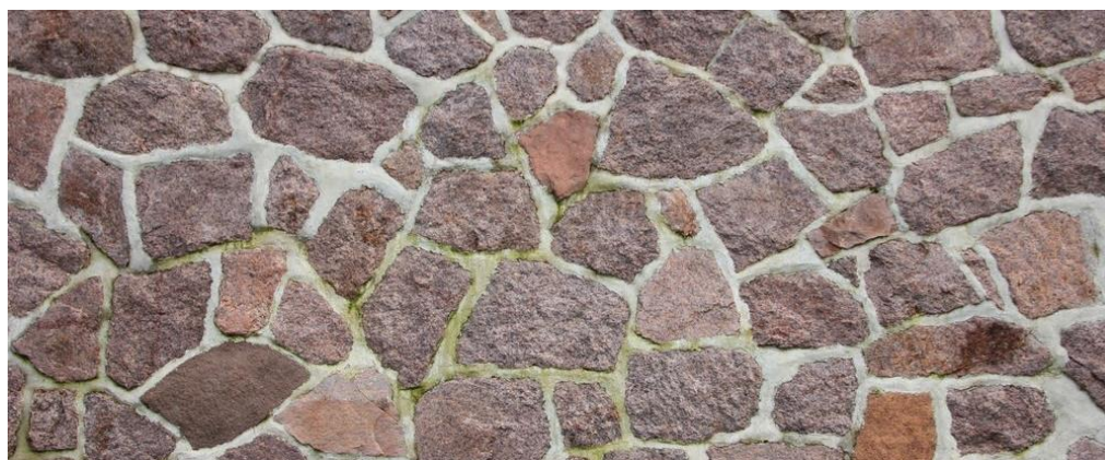
Figura 66: Parede de alvenaria de pedra com junta argamassada ( Alvenaria com junta argamassada [sem data]).
