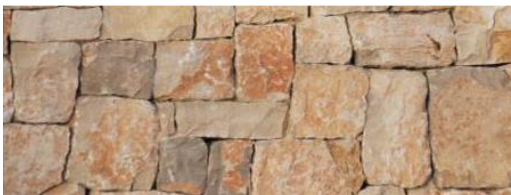
Figura 65: Parede de pedra em cantaria ( Mamposteria de la piedra [sem data]).
