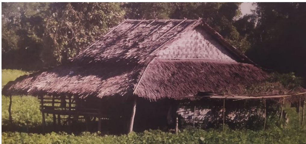
Figura 6: Exemplo de uma cabana de fazenda em Sri Ksetra Pyu, Myanmar, construída com troncos de árvores, esteiras de bambu, ripas e palha (Piesik 2017, p. 123).
