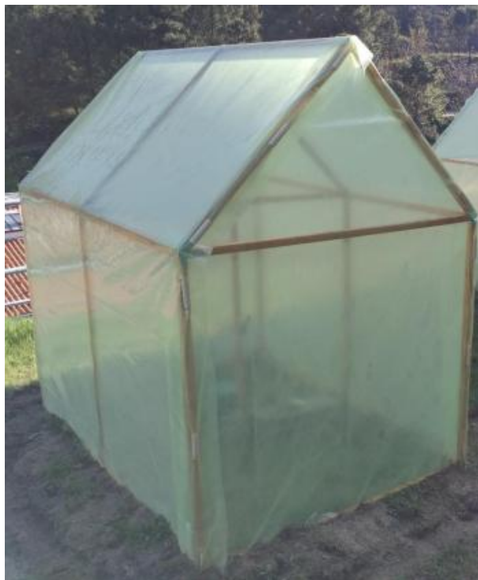
Figura 3.4 - Fotografia da estrutura da estufa com a cobertura instalada.
