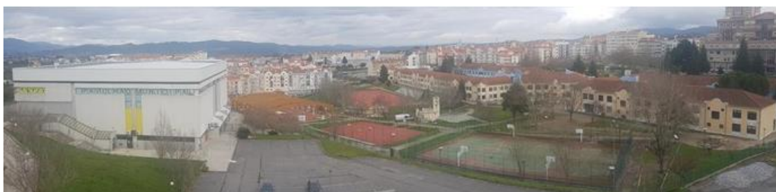
Figura 1. - Pavilhão e Espaços Exteriores da Escola
