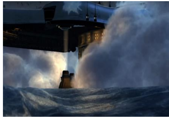
Figura 82 – Violência das ondas contra o cais devido a explosão (2012 )
