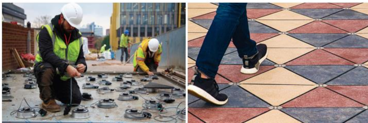
Figura 44: Pavegen na Universidade de Birmingham [78].
