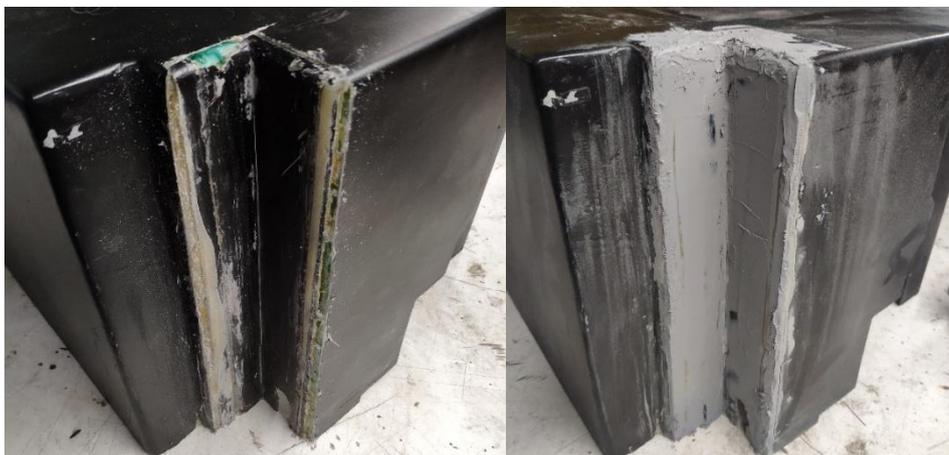
Figura 65 - Detalhe da reparação da caixa de proteção.
