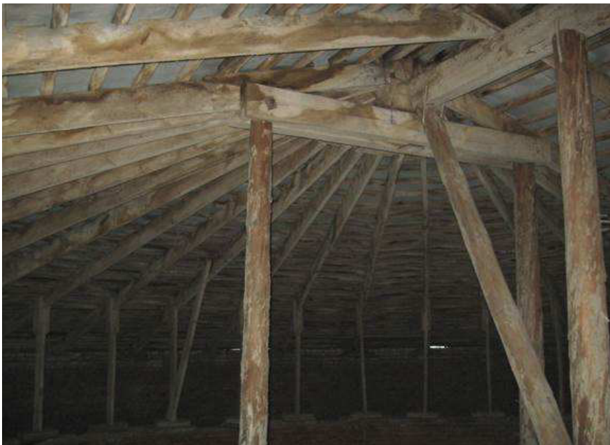
Рис. 1. Вплив агресивного середовища (атмосферних опадів) на дерев'яні конструкції
