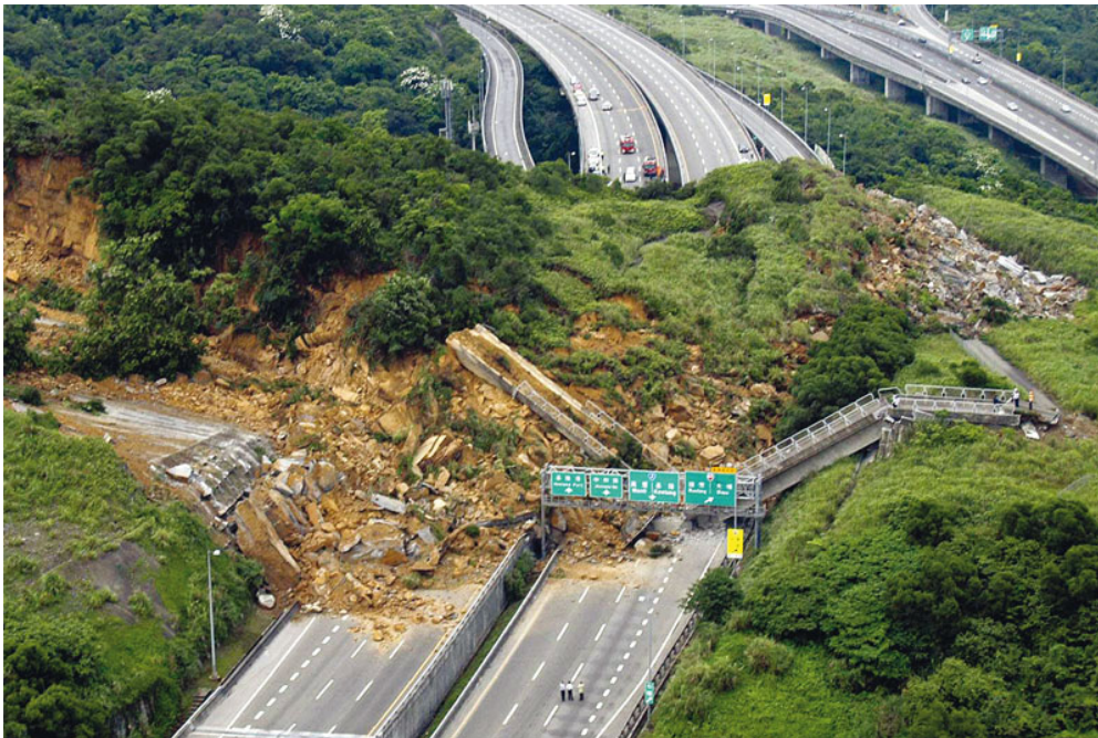
FIGURE 6.2 – Exemple de glissement de terrain à Taïwan le 25 avril 2010. Une autoroute a été ensevelie. (photographie issue du Figaro).
