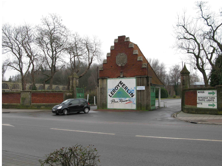
La fosse 1 des Mines de Nœux, occupée pendant 30 ans par une surface commerciale (photo Bénédicte Lefebvre)
