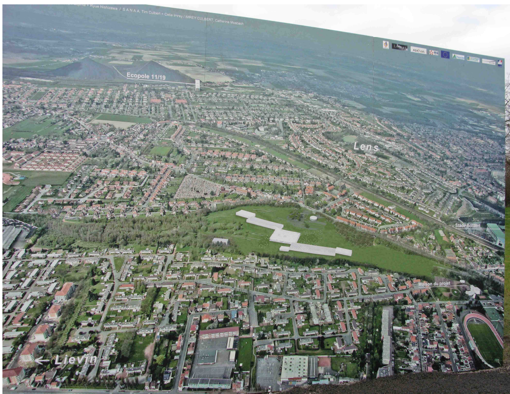
Photo aérienne du site de la fosse 9-9bis, avec l'emplacement du futur Louvre Lens. Panneau installé le jour de la pose de la première pierre, 4 décembre 2009 (photo Bénédicte Lefebvre)
