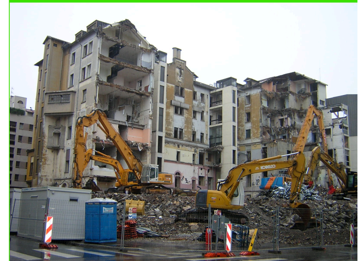
Lyon - démolition Hôpital St. Joseph
