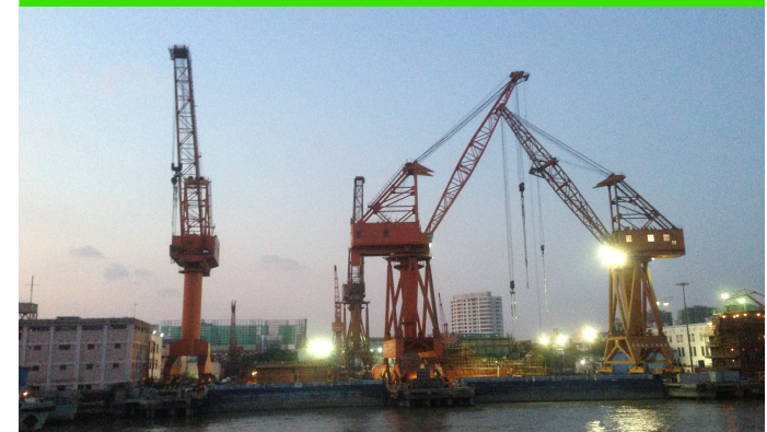
Shanghai – chantier du fleuve Yangpu – 03 septembre 2013
