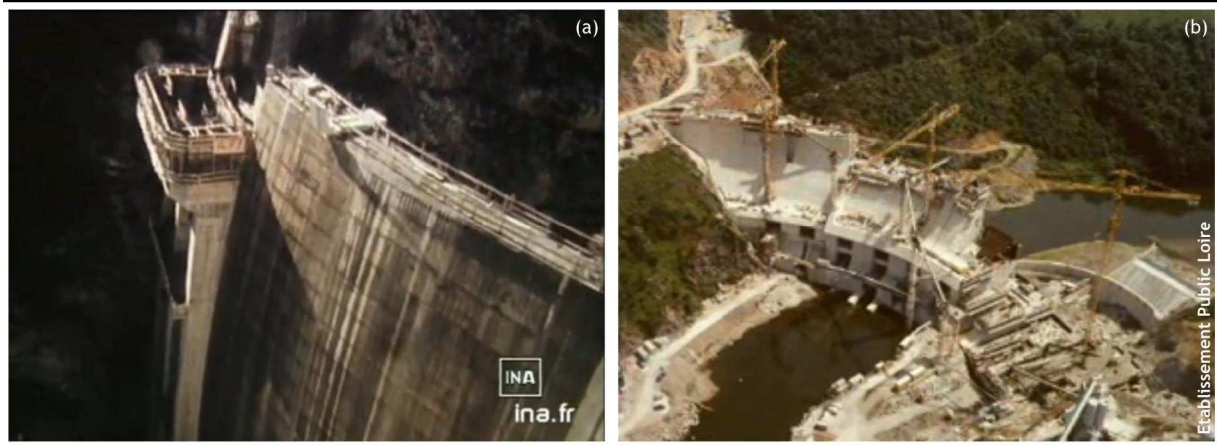
Figure 54 – Illustrations photographiques d'ouvrages structurants en construction faisant l'objet d'aides dans le cadre des programmes d'intervention des AE : (a) le barrage de Sainte-Croix sur le Verdon (AE RMC) (1973) et (b) le barrage de Villerest sur la Loire (AE LB) (1982).
