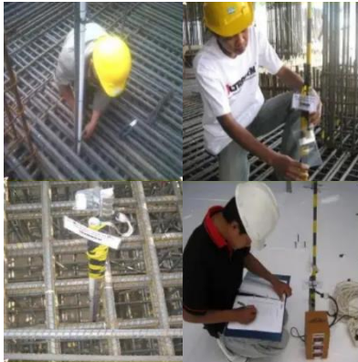
Gambar 6. Pemasangan thermocouple pada beton dan pembacaan temperatur
