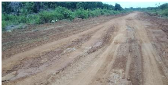
Gambar 8. Kondisi Jalan Dengan Perkerasan Tanah Merah (Hasil Dokumentasi, 2021)
