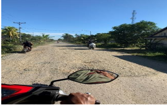
Gambar 6. Kondisi Jalan di Desa Teluk Keramat (Hasil Dokumentasi, 2021)
