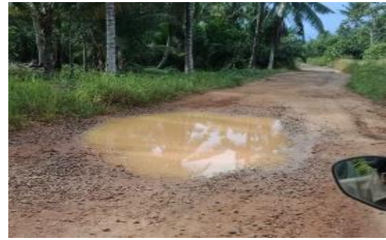
Gambar 9. Kondisi Lubang yang Ada di Jalan (Hasil Dokumentasi, 2021)
