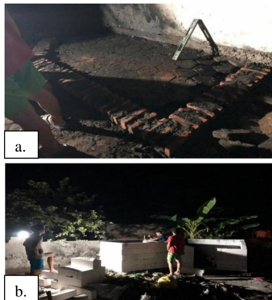
Gambar 2. Proses pembuatan komposter dan tempat sampah permanen (a) pembersihan lahan; (b) membangun fondasi
