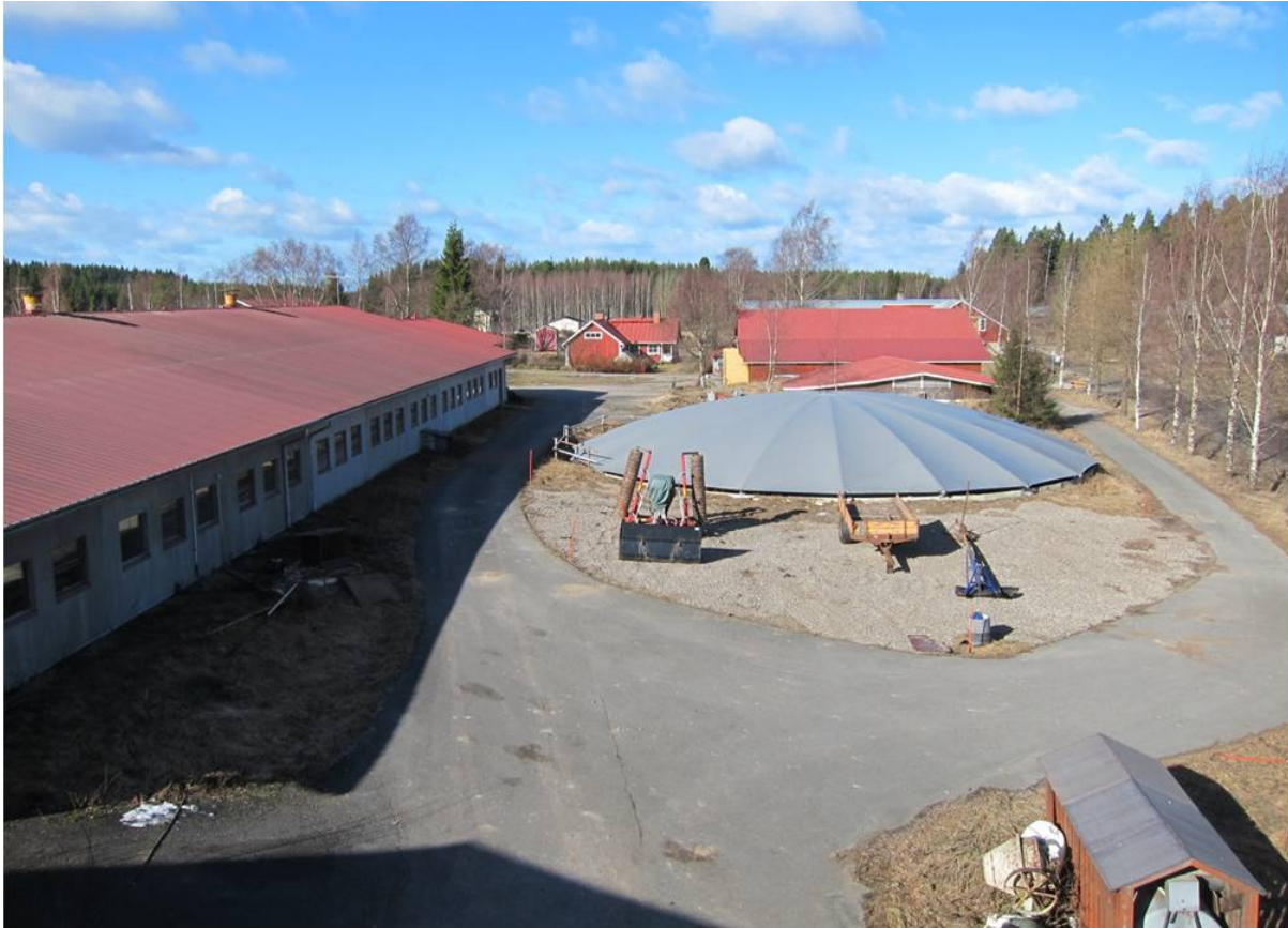
Kuva 2. Katetut lietesäiliöt: 600 \text{ m}^3 (peltikate) takana ja 1500 \text{ m}^3 (pressukate) edessä.
