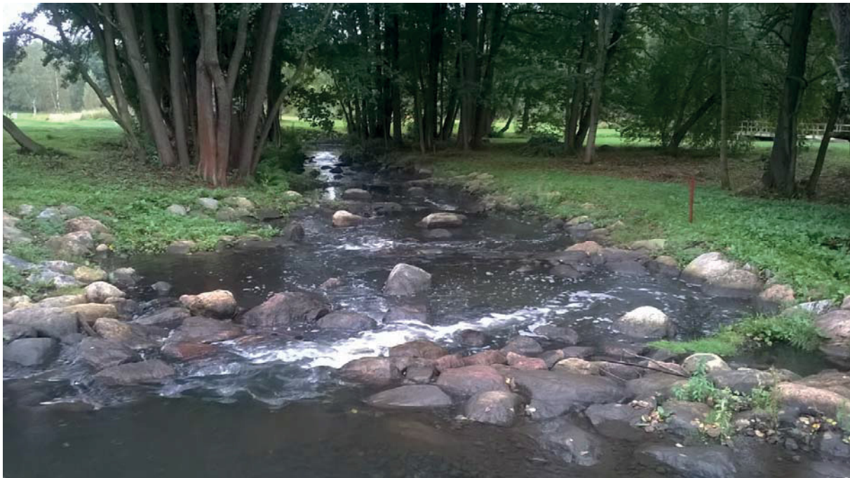
Kuva 3. Koeala 1 sijaitsee vuonna 2013 tekokoskeksi porrastetun kynnyksen alaosassa. Tekokoski on parissa vuodessa sulautunut ympäröivään maisemaan ja toimii hyvin kalojen nousu- ja taimenen lisääntymis- ja poikastuotantoalueena.
