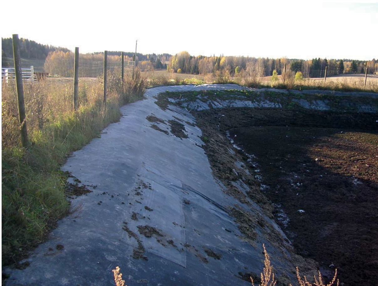
Kuva 12. Rikkoontunut allas voidaan paikata materiaalitoimittajan antamien ohjeiden mukaisesti. Kuva: Teemu Ala-Kleme.
