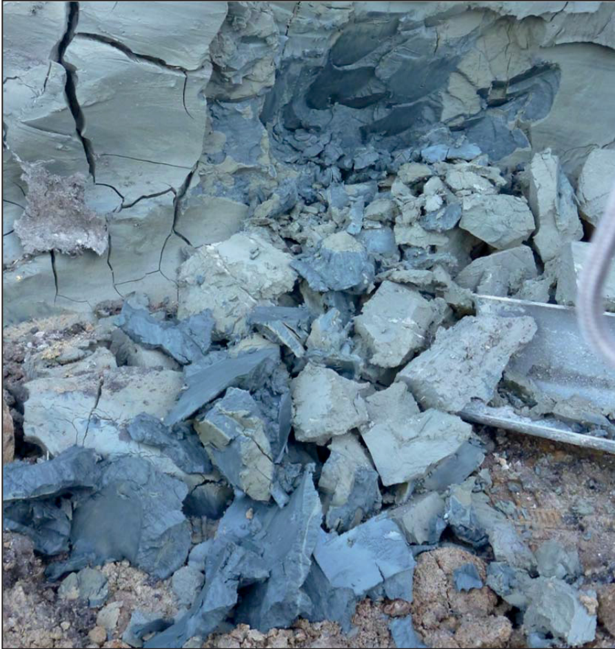
Kuva 6. Esimerkki massiivisesta eli rakenteettomasta sulfidihiesusta tietyömaaleikkauksessa Rovaniemellä. Maakerroksen pinta on hapettunut harmaaksi, mutta lapiolla kaivettaessa alta paljastuu musta hapettumaton sulfidi. Kuva: Pauliina Liwata-Kenttälä
