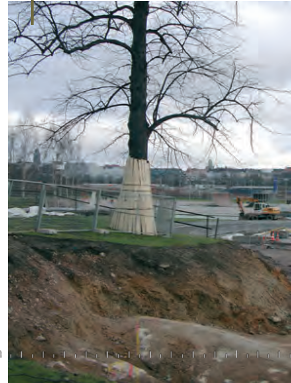
Kaupunkipuut joutuvat kestävämmän monenlaisia häiriötekijöitä. Kaivutyöiden yhteydessä juuristovauriot ovat yleisiä.
