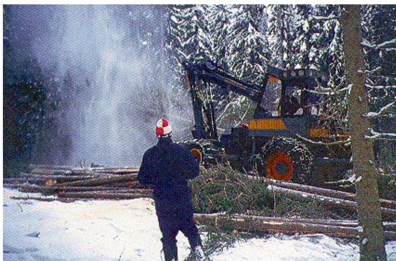
Kuva 3. Perinteinen avohakkuu meneillään eräällä itäisen tutkimuspaikkakunnan koeriuudulla talvella 1996. Hakkuustehdään teknis-taloudelliseen osahankkeeseen liittyvä aikatutkimus. Kuva tutkija Risto Lilleberg, Metsäteho.
