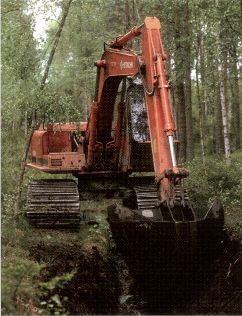
Kuva 7. Traktorikaivureista on siirretty kaivukoneisiin ja uudisojitukselta vanhojen ojaverkoston kunnostukseen. (Kuva: Markku Saarinen).
