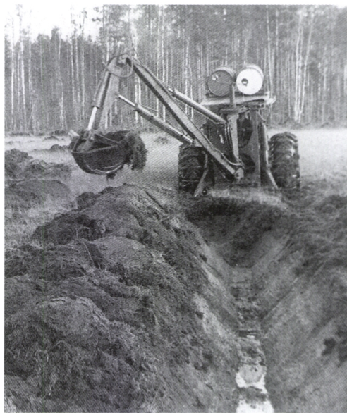
Kuva 6. Vammass-kaivuri nevaa ojittamassa vuonna 1970. (Kuva: Lusto/Markku Eskola).
