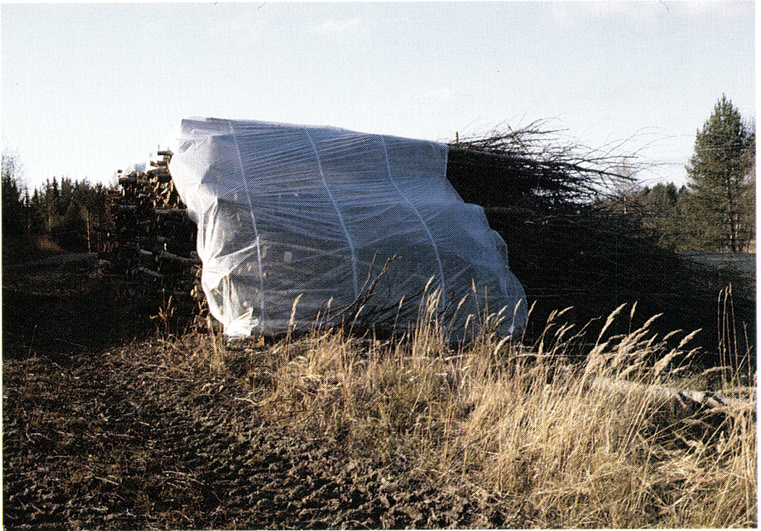
Lasikuituvahvisteinen muovi (Eurapeite) kiinnitetään reunoistaan hakasin ja narusidoksin.
