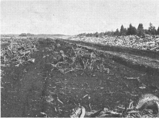
Kuva 14. MTP-26:n nostamia kantokasoja. Fig. 14. Stump piles extracted by a MTP-26.
