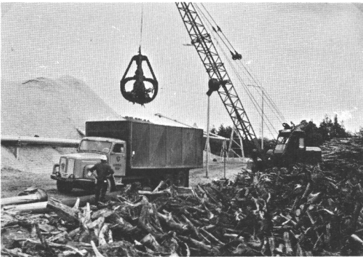
Kuva 2. Auton kuormausta kaivukoneella (Reitti II).
