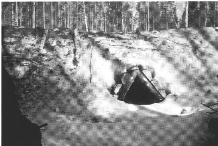
TAIGA Karjalan mallimetsähankkeessa paikan päällä tehty olosuhteisiin sovellettu rumpuratkaistu metsäautotiellä.
