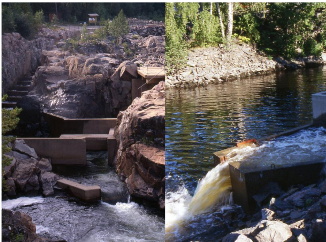
Kuva 7. Kaksi allastyypin kalatien ylivirtausaukkoa. Vasemman kuvan Kalixjoen Jockfallin kalatien ylivirtausaukko ei ole varsinainen kalatien sisäänkäyntiaukko, mutta kuvasta käy ilmi ylivirtausaukon toimintaperiaate. Oikeanpuolimmaisesta kuvasta Hvitvingfossenin (Norja) kalatien suun ylivirtausaukossa putouskorkeus on alavedenpinnan laskun myötä kasvanut liian suureksi ja kalojen hakeutuminen kalatiehen on hankaloitunut. Kuvat: A. Laine, Pohjois-Pohjanmaan ELY-keskus.
