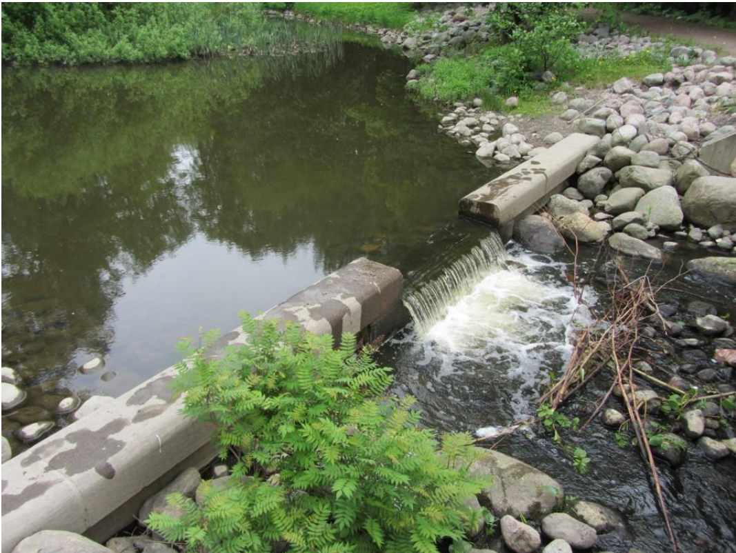
Kuva 9. Koealan 4 yläreuna rajoittui betoniseen pohjapatoon.
