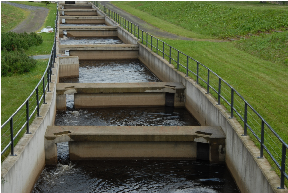
Kuva 4. Merikosken alakalatie (pystyrako-osuus, vain vasemman puoleiset pystyraot käytössä). Kuva: Panu Orell.
