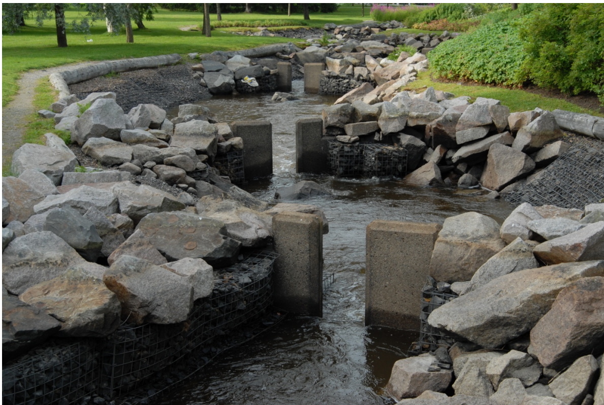
Kuva 10. Runsaiden ohjuuksutusten vuoksi Merikosken voimalaitoksen yläveden pinta laski huomattavasti elokuussa 2012, jolloin myös yläkalatiehen johtuva virtaama ( <0,3 \text{ m}^3/\text{s} ) oli heikko. Kuva: Panu Orell.
