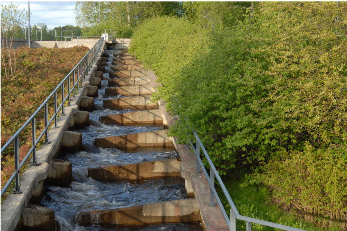
Kuva 6. Merikosken yläkalatien yläosan pystyrako-osuus. Kalatie yhtyy voimalaitoksen yläkanavaan kuvan vasemmassa yläreunassa näkyvän lyhtypylvään takaa. Kuva: Panu Orell.
