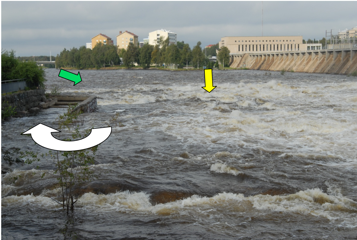
Kuva 9. Elokuussa 2012 runsaat sateet johtivat poikkeuksellisen suurin ohjuuksutuksiin Merikosken voimalaitoksella. Tällöin vaelluskaloilla oli mahdollisuus nousta yläkalatien alapuolelle (valkoinen nuoli) alakalatien (keltainen nuoli) ohella myös Oulujoen vanhaa uomaa myöten (vihreä nuoli). Kuva: Panu Orell.
