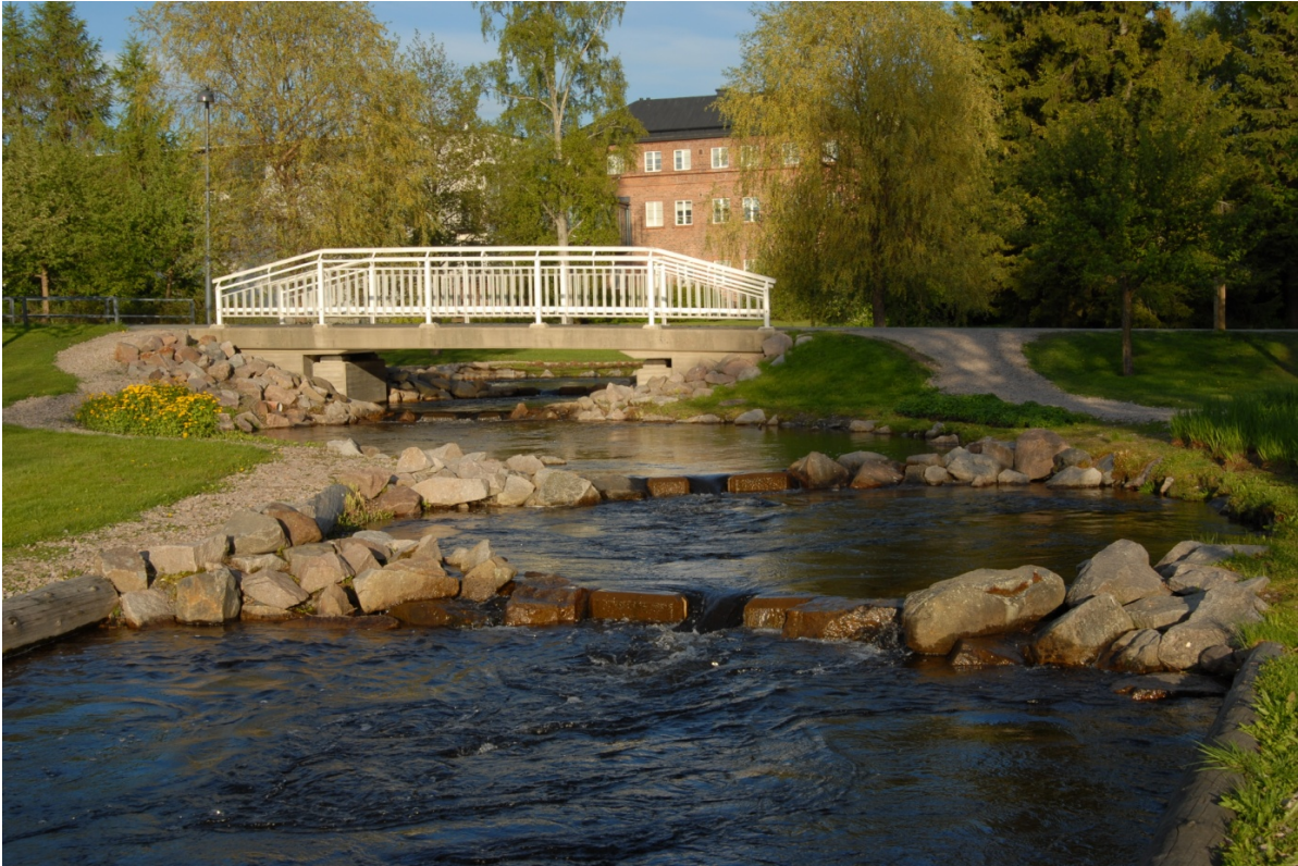
Kuva 5. Merikosken yläkalatien luonnonmukaisen kaltaiseksi rakennettu osuus. Kuva: Panu Orell.
