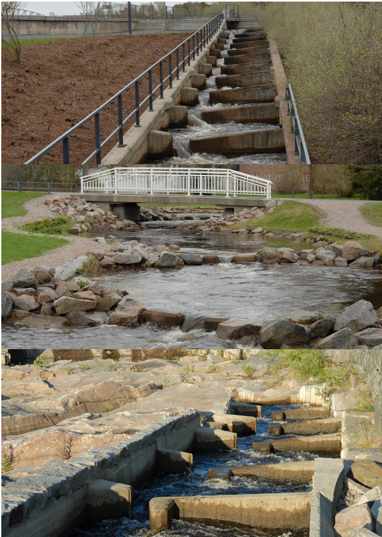
Kuva 2. Merikosken yläkalatien eri osat. Yläkalatien ylä- (ylin kuva) ja alapäässä (alin kuva) on betoninen pystyrako-osuus, joiden väliin jää luonnonmukaisen kaltainen puromainen osuus (keskimmäinen kuva). Valokuvat: Panu Orell.
