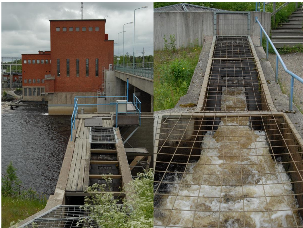
Kuva 4. Isohaaran vanha vuonna 1993 valmistunut kalatie koostuu sekä Denil (kuvissa) että pystyrakotyyppisistä kalatieosuuksista. Kuvat: Panu Orell.
