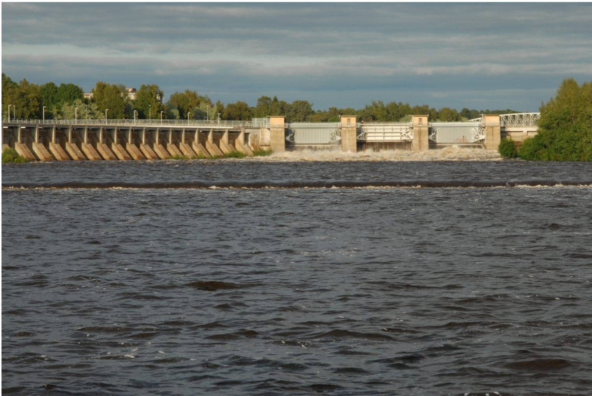
Kuva 12. Vaelluspoikasia voidaan ohjata voimalaitosten ohitse säännöstelypatojen kautta. Useimmiten tämä edellyttää kuitenkin säännöstelypadolta juoksutettavan vesimäärän lisäämistä. Kuva: Panu Orell
