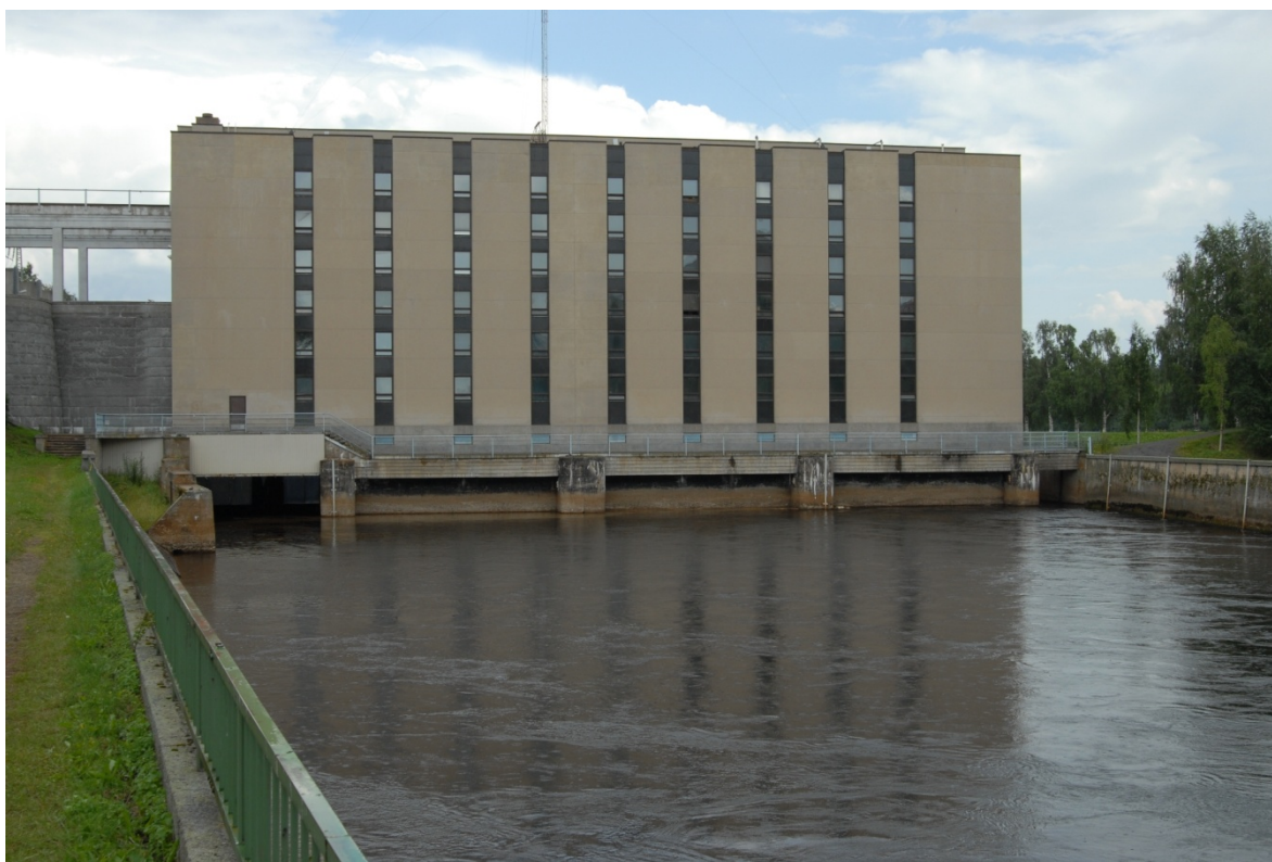
Kuva 3. Vesivoimalaitosten rakentaminen on muuttanut suuresti jokien virtausolosuhteita ja uomamorfologiaa. Kuva: Panu Orell
