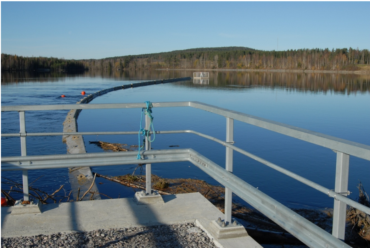
Kuva 11. Umeå-joen Stornorrfors-voimalaitoksen kelluva alasvaellusohjuri. Kuva: Panu Orell
