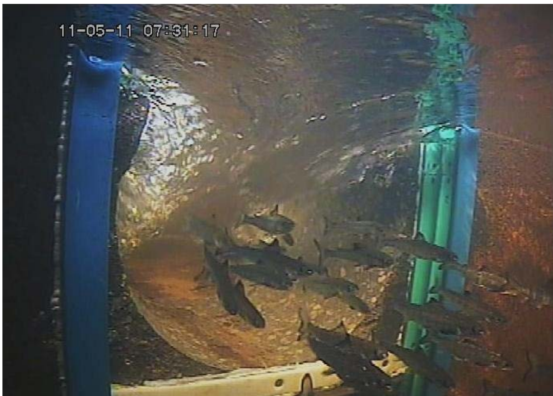
Kuva 13. Yksinkertaisimmillaan vaelluspoikasten alasvaellusväylä voi olla voimalan rakenteisiin tehty putkirakenne. Kuvassa lohien vaelluspoikasia hakeutumassa alasvaellusväylään. Kuva: Anders Lamberg
