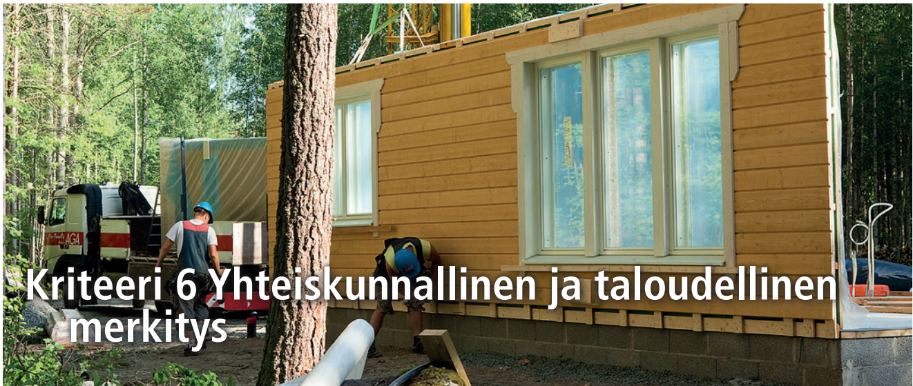
Omakotitalon seinäelementin asennus.
