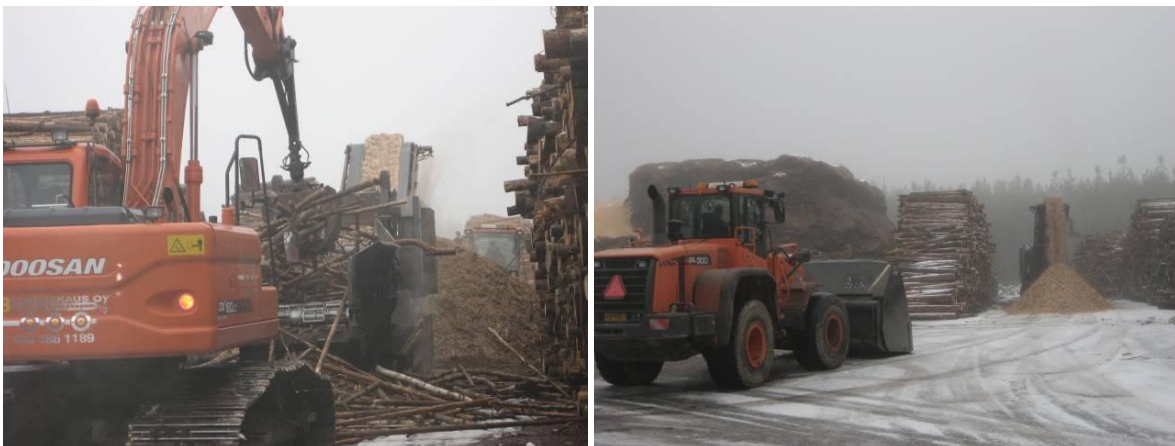
Kuva 32. Vasemmalla kaivinkone syöttökoneena ja oikealla pyöräkuormaaja aumaukseen.
