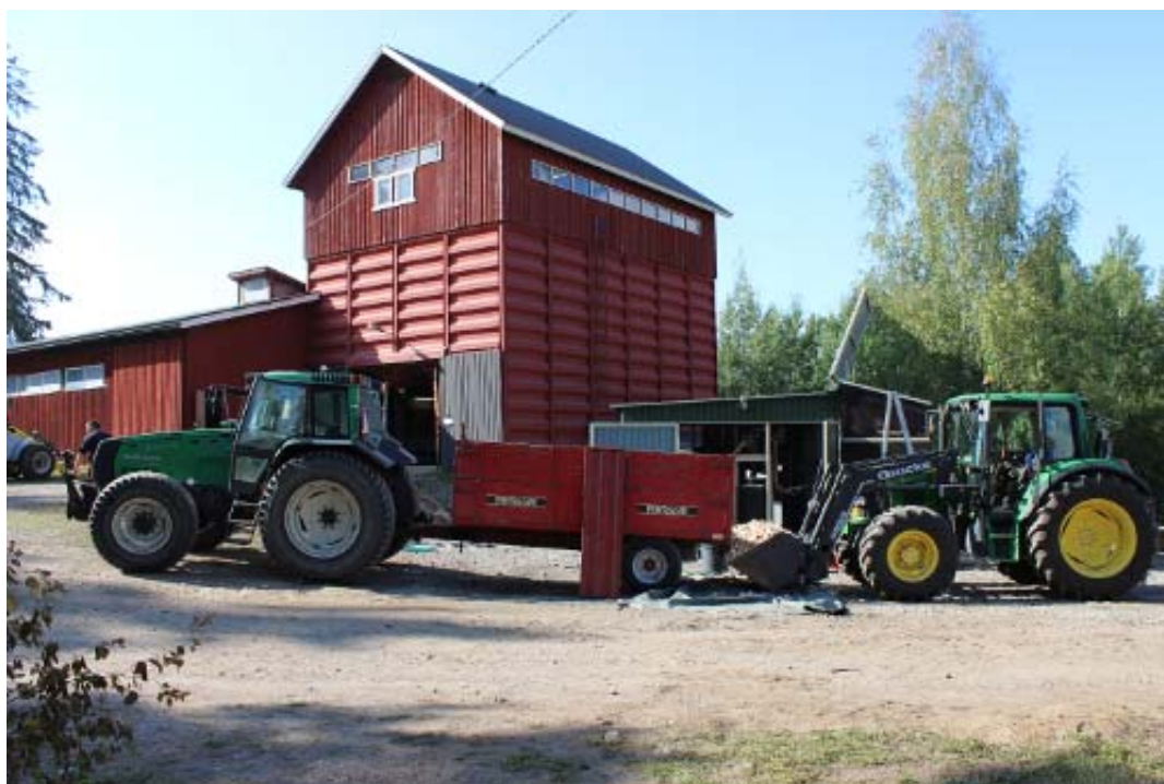
Kuva 5. MTT Vakolan kuivuri on osa Cropinfra tutkimusalustaa. Puukaasulaitteisto sijoitettiin kuivurin pannuhuoneen viereen mittauksia varten tehdyille mursketasanteelle.
