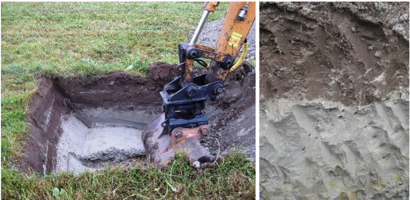
Kuva 2. Kuopan kaivuu käynnissä 18.9.2013. Muokkauskerroksen alta paljastui hyvin vaalea karkea hieta.
