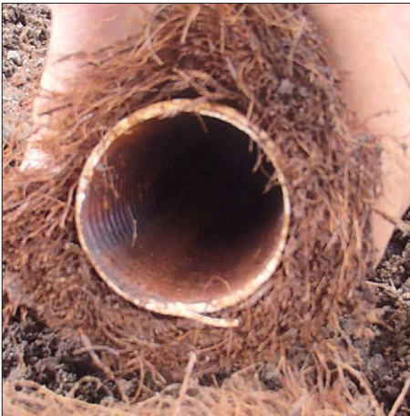
Kuva 3.69. Kalajoki 4–5. Kookoskuitu oli säilynyt hyvin maassa. Putket olivat puhtaita.
