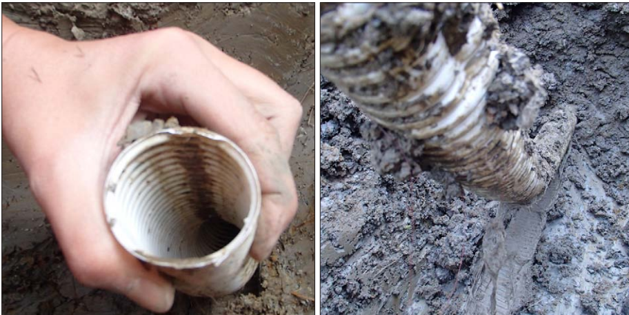
Kuva 3.47. Loimaa. Kohteen kaikki putket olivat hyvin puhtaita. Kuva 3.48. Loimaa. Suodatinkangas oli hajonnut lähes kokonaan molemmilla lohkoilla.
