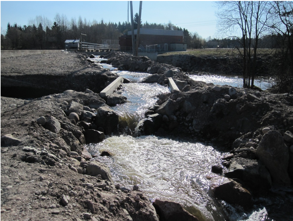
Kuva 15. Eurajoen Pappilankoskeen on rakennettu kalatie. (kuva: Henri Vaarala)
