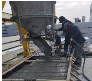
(f) Concrete pouring
