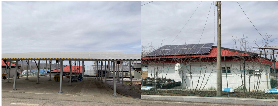
그림 22 비닐하우스 제거 후 태양광 설치 (연구자 촬영 2021. 4. 2.)
