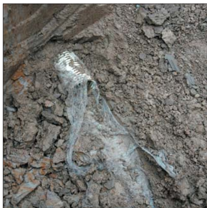
Kuva 8.1. Köyliön Vanhakartano, lohko 7, piste 7a. Maalaji on salaojasyvytydessä hieua ja savespitoisuus on 7,6 %. Esipäällyste on haurastunut kymmenessä vuodessa.
