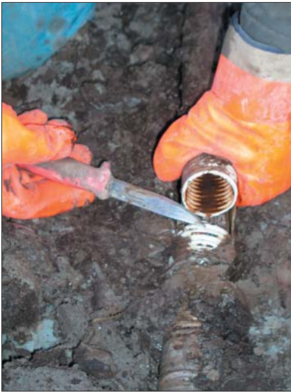
Kuva 8.10. Esimerkki Maaningan kohteesta, jossa on käytetty ohutta suojakangasta (Fibrella). Maalaji on ojitussvyvydessä hieta ja maan savespitoisuus on 10 %. Ojitus on tehty vuonna 2005. Putkessa on vain hieman ruostesaostumia.
