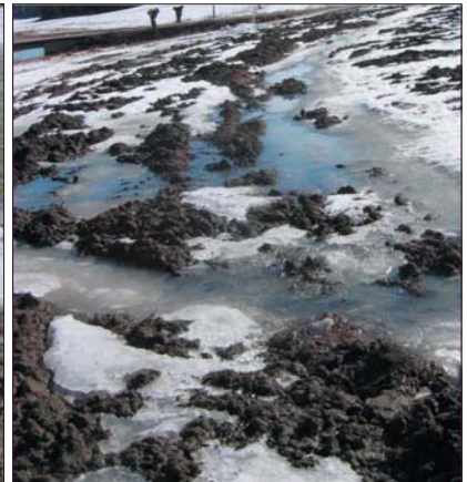
Kuva 5.3. Gårdskullan alue 2, sulantavedet valuvat vielä jäässä olleen pintakerrosvaluntakeräimen yli 3.4.2009.
