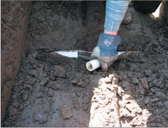
Kuva 8.8. Esimerkki Joroisten kohteesta, jossa on käytetty ohutta suojakangasta (Fibrella). Maalaji on ojitussvyvydessä hieta ja maan savespitoisuus on 8 %. Ojitus on tehty vuonna 2007 eikä saostumia ole.
