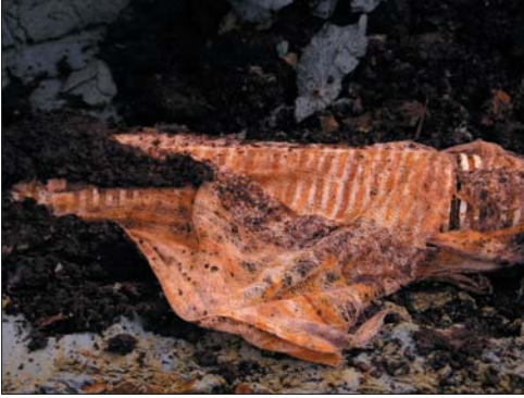
Kuva 8.5. Alavieska, kohde 3. Ohut esipäälyste kymmenen vuotta vanhassa ensiojituksessa. Maalaji on ojitussyvydessä hiue ja putki on hyvin ruokamullalla suojattuna. Suojakangas on osittain haurastunut.
