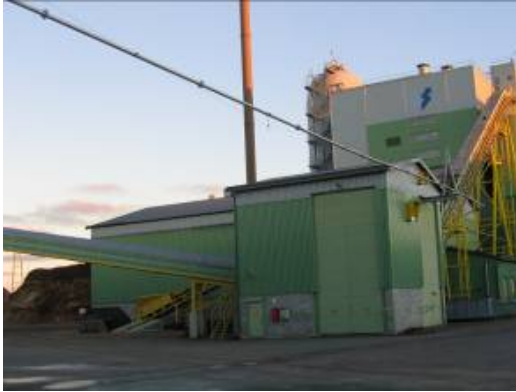
Kuva 62. Pneumaattinen syöttölinja varastohallilta kattilarakennukseen ja syöttö suoraan kattilaan seospolttoaineiden syöttökohtien välissä (kuvat: Risto Impola).
