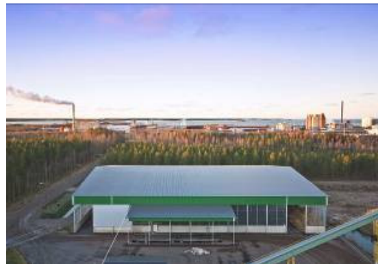
Kuva 60. Kokkolan voimalaitokselle rakennettu katettu helpipaalien varastohalli, jossa myös paalit murskataan (kuvat: Samuli Rinne).
