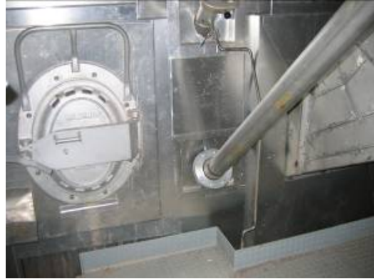
Kuva 62. Pneumaattinen syöttölinja varastohallilta kattilarakennukseen ja syöttö suoraan kattilaan seospolttoaineiden syöttökohtien välissä (kuvat: Risto Impola).
