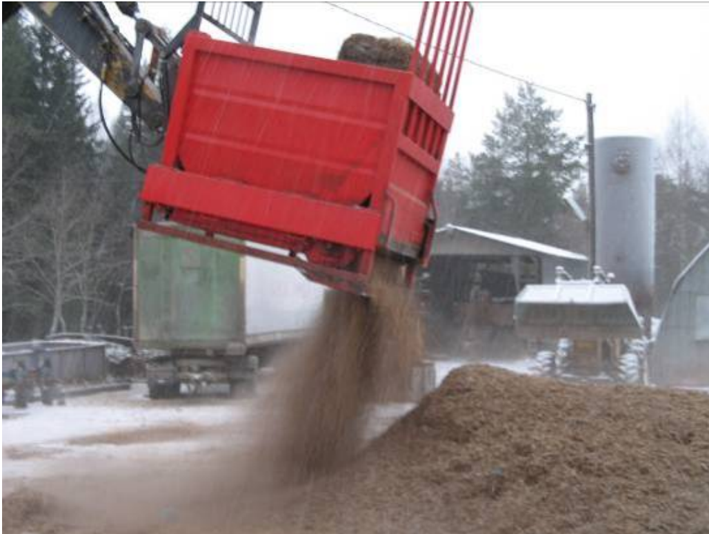
Kuva 20. Kaivinkoneeseen asennettava murskain (kuva: Teuvo Paappanen).
