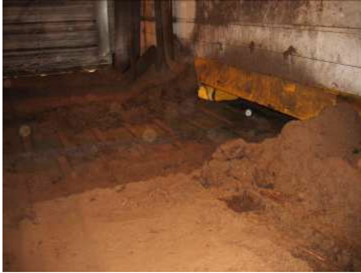
Kuva 29. Yliajettava kolapohjapurkaimella varustettu turpeen vastaanottoasema Pursi- alan voimalaitoksella (kuva: Risto Impola).
