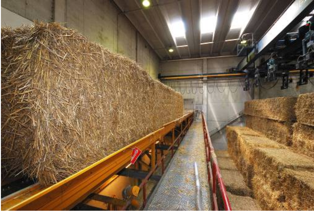
Kuva 65. Olkipaaleja Dong Energyyn Studstrupin voimalaitoksen paaliradalla menossa murskaukseen. Oikealla näkyvät paalinosturit. Rekkoja purettaessa nosturien pihdeissä olevat anturit mittaavat paalien kosteuden mikroaaltotekniikkaan perustuen (kuva: Samuli Rinne).
