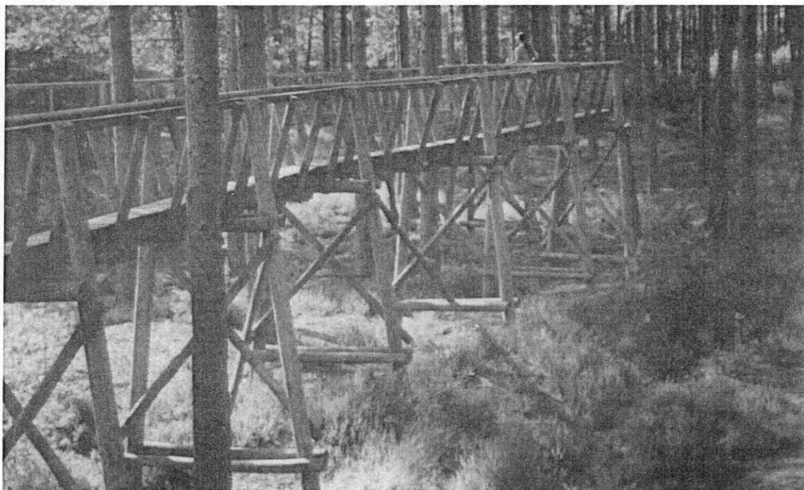
Kuva 28. Esimerkki pyöreän puun käytöstä ympäristörakenteista Englannista. Luonnonsuojelualan maapohjaa halutaan säästää kulutukselta, ja yleisölle on tehty "havaintopolku" noin 3 m korkeuteen maanpinnasta. Tällaiset rakenteet soveltuvat Suomeen vastaavanlaisiin tilanteisiin, eläinpuistoihin, luonnonsuojelualueille, lintuhavainnointipaikkoihin jne.
