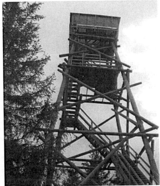
Kuvat 9 ja 10. Pyöreästä puusta rakennettu näkötorni, vasemmalla esimerkki Hollannista ja oikealla Suomesta.
