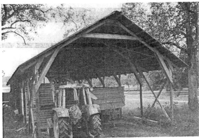
Kuva 46. Esimerkki kevyestä kolminivelkehä-katoksesta: kehän nurkkavahvikkeet on tehty sahalaudasta, harjaliitos on varmistettu kitapuulla (sahalautaa).
