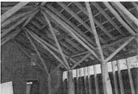
Kuva 5. Pyöreästä puusta tehty vaativa ja koris- teellinen rakenne (Iso-Britannia).
