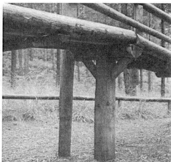
Kuvat 35 ja 36. Vasemmalla puupilari on perustettu betoniin pultattuun teräslevyyn naulauslevyjen väliyksellä, puun kostuminen on minimoitu rakenteellisin toimenpitein. Oikealla painekyllästetty pilari on upotettu suoraan maahan. Tässä tapauksessa pilarin ympärystä on tiivistetty karkealla, vettä hyvin läpäisevällä soralla.
