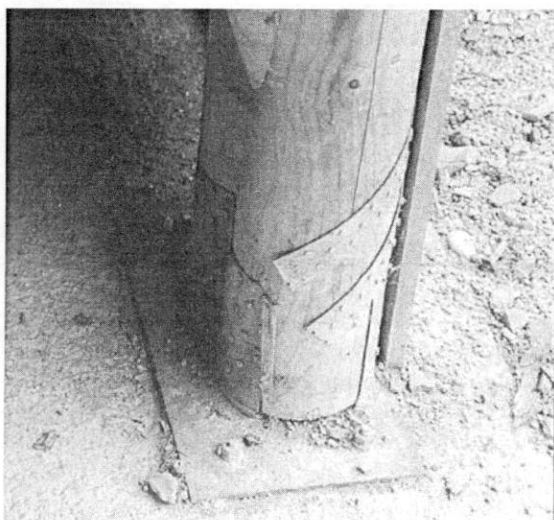
Kuvat 35 ja 36. Vasemmalla puupilari on perustettu betoniin pultattuun teräslevyyn naulauslevyjen väliyksellä, puun kostuminen on minimoitu rakenteellisin toimenpitein. Oikealla painekyllästetty pilari on upotettu suoraan maahan. Tässä tapauksessa pilarin ympärystä on tiivistetty karkealla, vettä hyvin läpäisevällä soralla.
