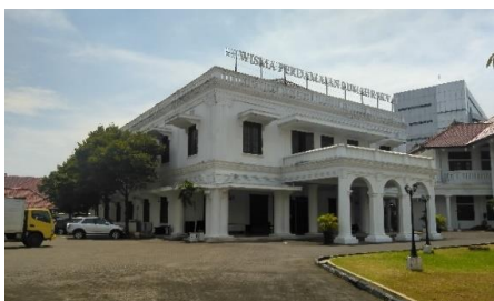
Gambar 2: Bangunan Kuno Wisma Perdamaian (Sumber: Dokumentasi Penulis, 2021)
