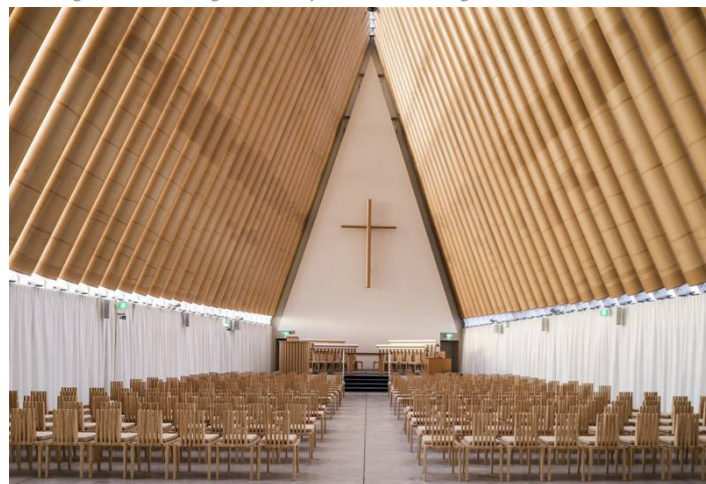
[im. XVI] Catedral de cartón . Christchurch, Nueva Zelanda. Shigeru Ban (2013). Catedral temporal tras la devastación de un terremoto. Estructura simple compuesta de tubos de papel para la cubierta y contenedores para capillas y almacenaje.
