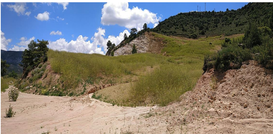
FIGURA 2. FOTO DE UNA RESTAURACIÓN GEOMORFOLÓGICA. MINA DE CAOLÍN RECIENTEMENTE RESTAURADA UTILIZANDO LA APROXIMACIÓN GEOMORFOLÓGICA EN EL RIODEVA (TERUEL). FUENTE: JAUME TORMO BLANES.
