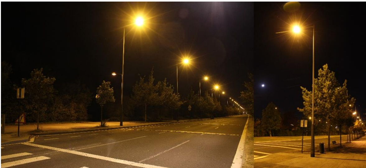
Figura 80: Luminarias de Salburua. Fuente: Elaboración propia.
