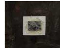
limpieza química con sistema acuoso gelificado
