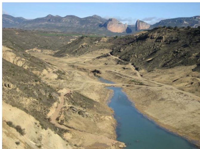
Figura 1. Estado del vaso del embalse previo a su llenado y tras finalizar su construcción. (CHE, 2007)
