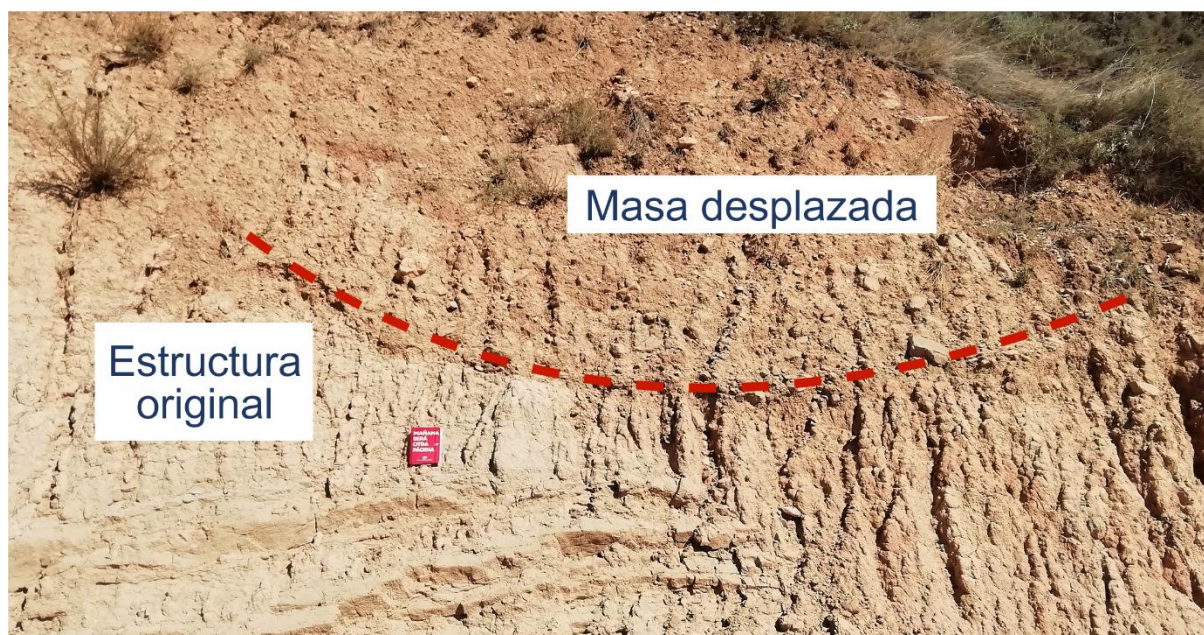
Figura 9. Deslizamiento menor dentro del deslizamiento I-13. Se aprecia la superficie de deslizamiento (línea a trazos) sobre la que se distorsiona la estructura original.
